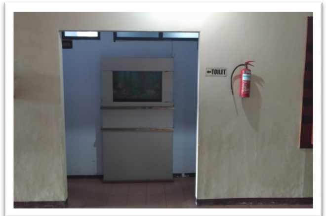
Toilet di Dekat Ruang Tunggu
